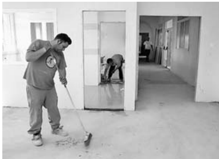
Operarios trabajan ayer en la ampliación del centro. :: ANDY SOLÉ
